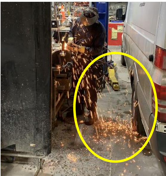
FIGURE 10 — Des étincelles sont projetées sur le véhicule - aménagement non sécuritaire
