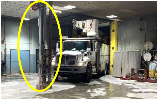
FIGURE 6 — Un poteau structural dans le milieu du garage, ce qui complique les manœuvres pour entrer et sortir les véhicules - risque d'accrocher le poteau
