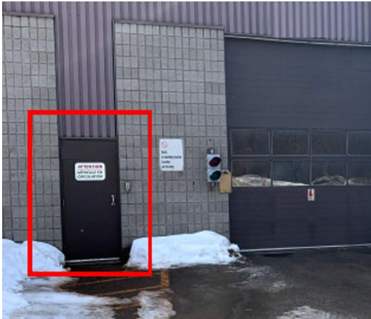
Photo 8 – Porte d'accès non barrée sans aucune serrure – ouverte 24 h/24
