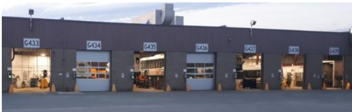
Photo 4 – Vue extérieure de baies de l'atelier mécanique
