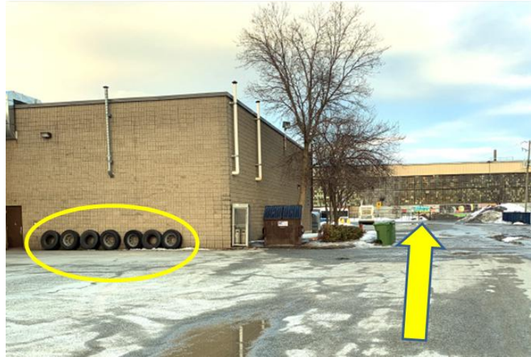
Photo 13 – Pneus appuyés sur un mur. Sortie donnant un accès direct à la rue – clôture non barrée
