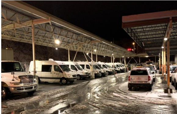
FIGURE 2 — La cour intérieure chez Hydro-Sherbrooke permet le stationnement des véhicules à l'abri sous un toit à ciel ouvert, ce qui est une bonne pratique
