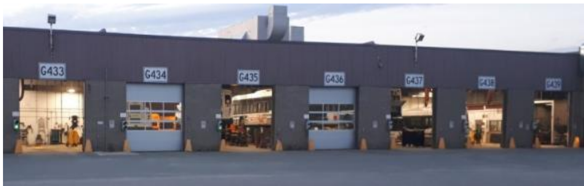
Photo 4 – Vue extérieure de baies de l'atelier mécanique
